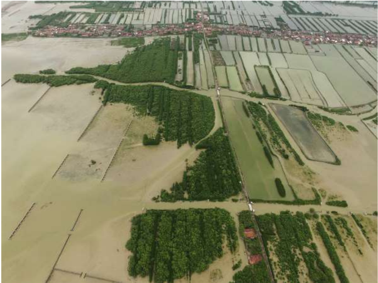
Struktur permeabel di lepas pantai Demak, Indonesia. Foto milik Building with Nature Indonesia.
